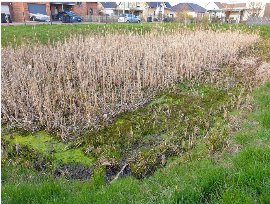
Abb. 5 Regenrückhaltebecken: flach eingestauter Zustand im April 2022 (Foto: 13.04.2022)
